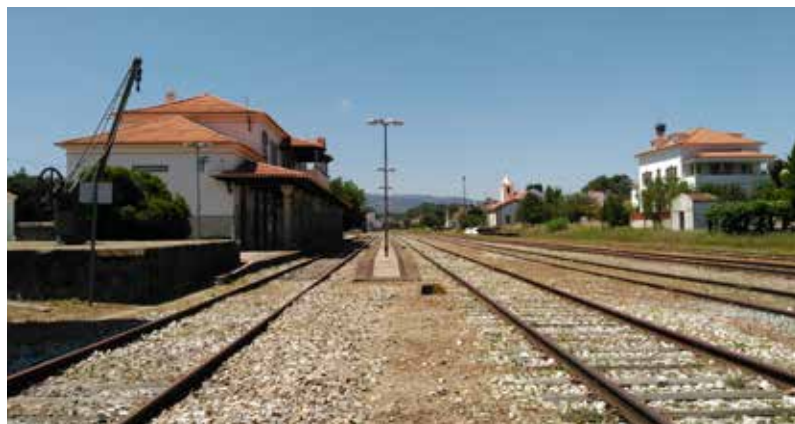
Beirã train tracks and infrastructures Linhas de comboio e infraestruturas da Beirã Infraestructuras y vías del ferrocarril en Beirã
