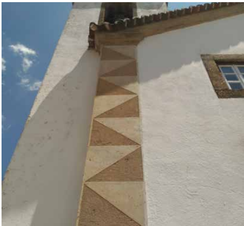
Sgraffito finishings in Marvão Esgrafiados em Marvão Esgrafiados en Marvão
