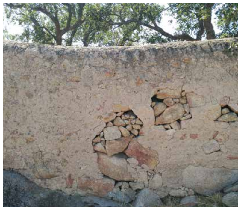
Masonry wall in Beirã, finished in a mortar which mixes lime and local earth Muro de alvenaria na Beirã, acabado com argamassa de cal e solo local Muro de mampostería en Beirã, acabado con mortero de cal y tierra local
