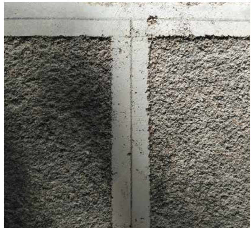
Sgraffito finishings in Castelo de Vide Esgrafiados em Castelo de Vide Esgrafiados en Castelo de Vide
