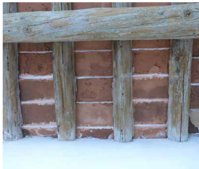
Wooden beams and ceramic tiles structure in Évora Vigas de madeira forjadas e elementos cerâmicos em Évora Forjado de vigas de madera y elementos cerámicos en Évora
